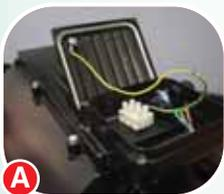
**A** Caixa de ligação com bornes e ponto de aterramento.
